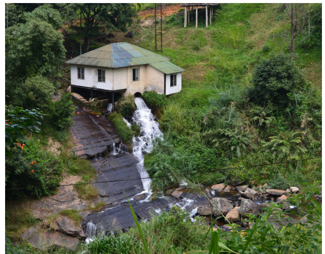
Sala de máquinas de una minicentral hidroeléctrica.
